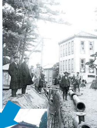
創設当時の工事
