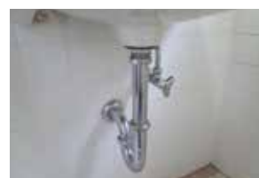
敷地内の排水設備が破損していないか、漏れていないか、汚水のおいしくないかなど確かめましょう。
