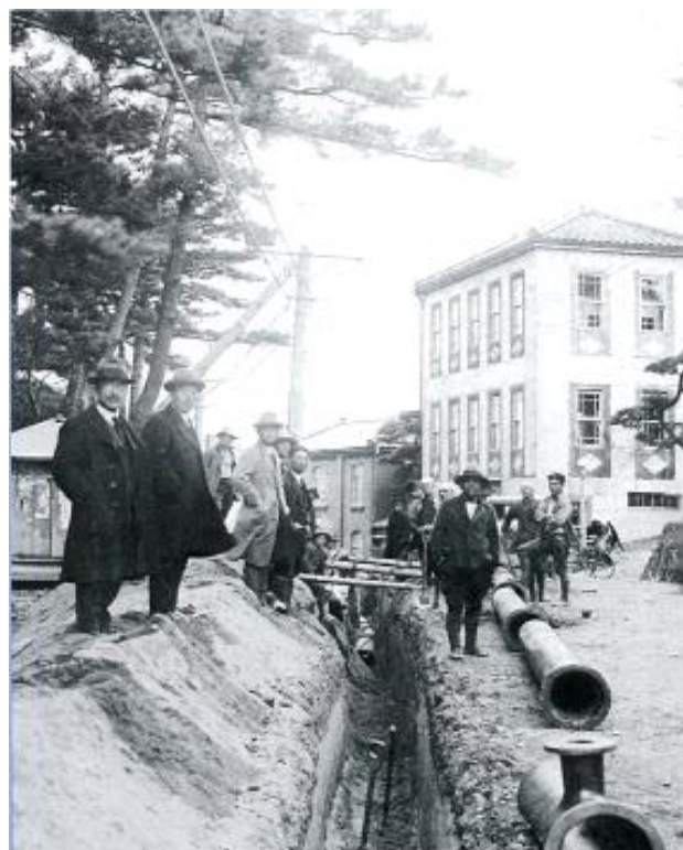
昭和初期の工事風景（右は旧割烹小幡）
