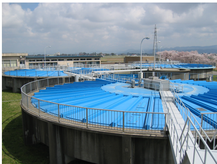
小牧浄水場 高速沈でん池
