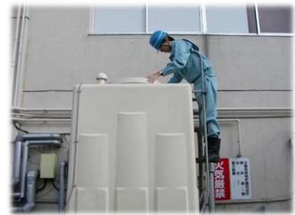
▲衛生部局からの委託による貯水槽の点検
