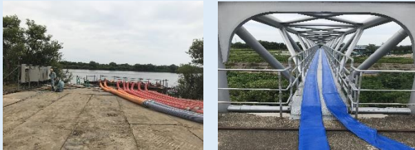
▲塩水遡上対策（仮設ポンプ設置による上流からの取水）
