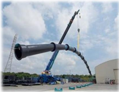
▲耐震管の吊下げ試験
