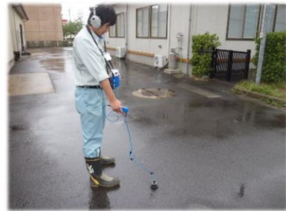
▲漏水探知機で地下の水道管の漏水を調査
