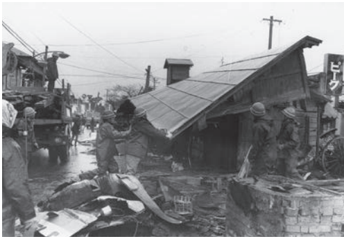
昭和51年(1976) 柳小路マーケットの解体
