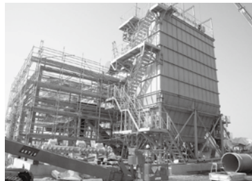
大型集塵装置の施工風景
