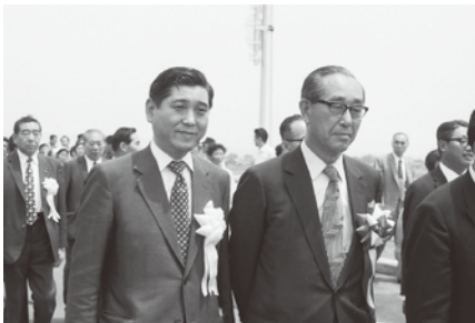
S47.6.17出羽大橋開通式
