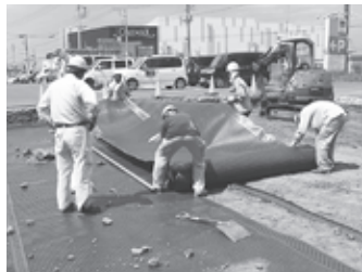
ジオ・ダブルサンド工法の施工
