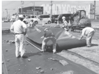
ジオ・ダブルサンド工法の施工
