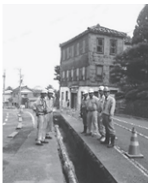
▲約80年後の水道管更新工事
