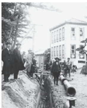
▲昭和5年当時の工事風景 (旧割烹小幡前)
