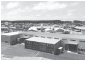
本社工場(平成27年7月竣工)
