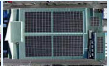
▲同店舗屋根に設置された計532枚の太陽光パネル (写真提供：(株)トー屋)
