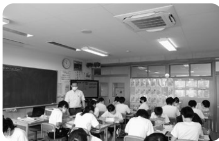
エアコンが設置された教室
