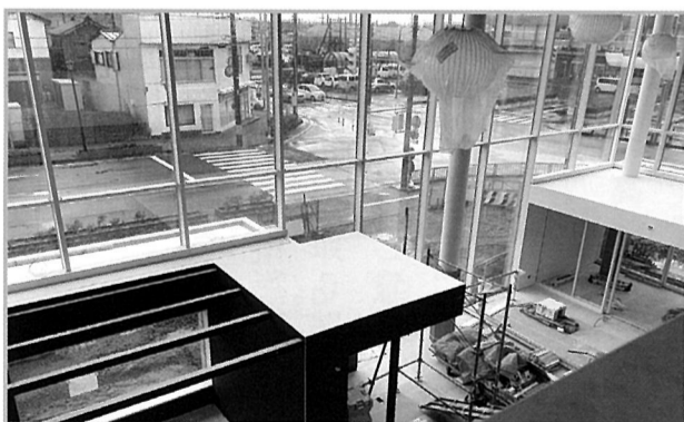
駅前ミライニの建設現場
