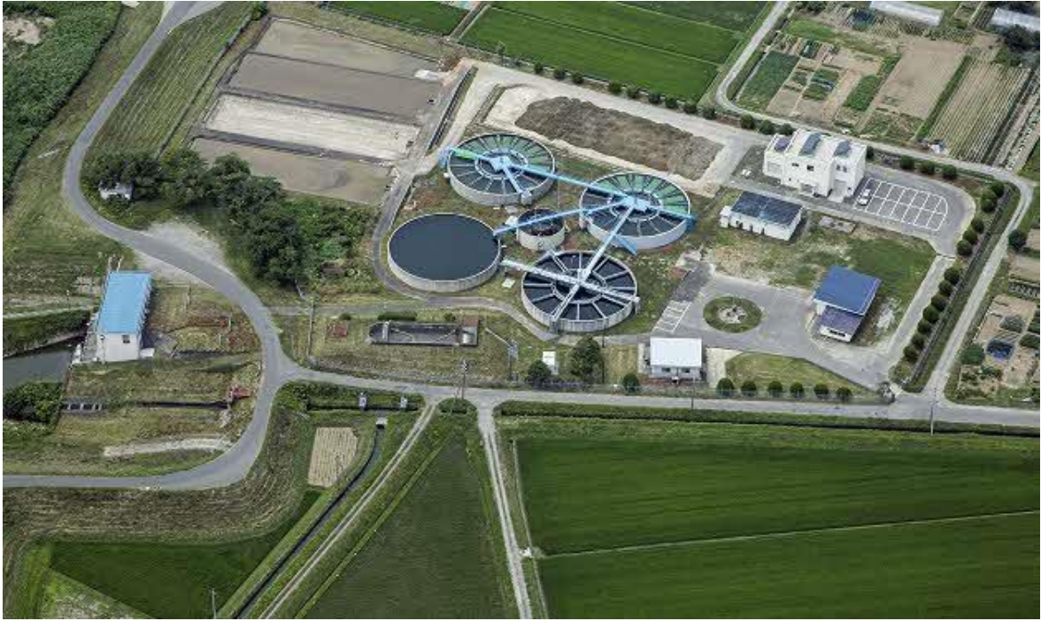
○酒田工業用水道 遊摺部浄水場の全景
