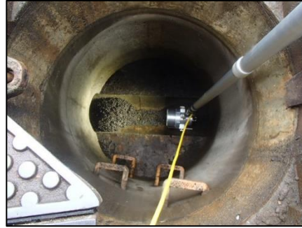
カメラ調査状況
