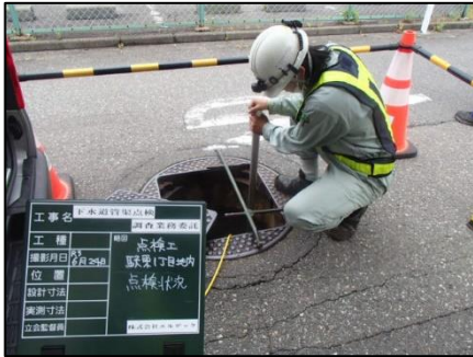
カメラ調査状況
