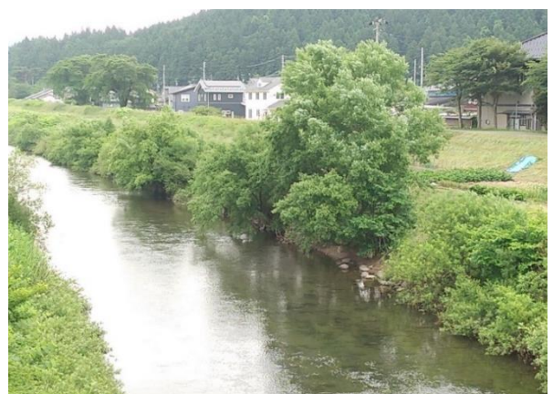
水辺に支障木が繁茂する荒瀬川
