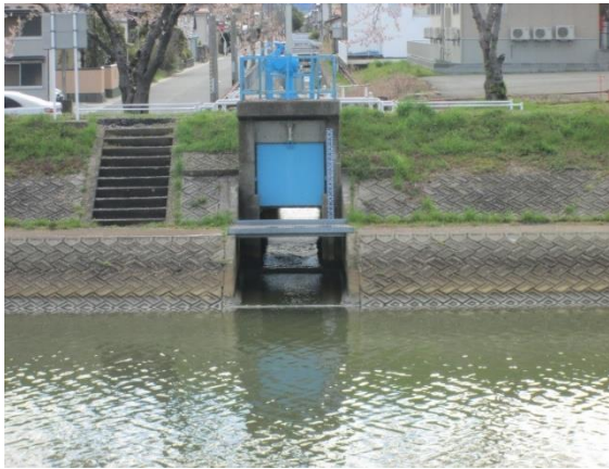
新井田川から札谷地樋門を望む
