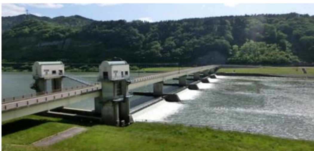
最上川さみだれ大堰
