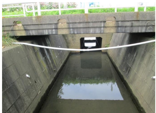
札谷地雨水幹線→樋門（断面縮小）
