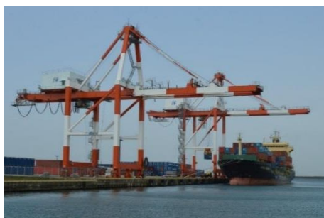
高砂埠頭のコンテナクレーン
