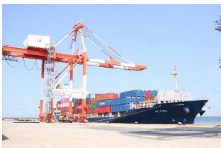
高砂ふ頭のコンテナクレーン
