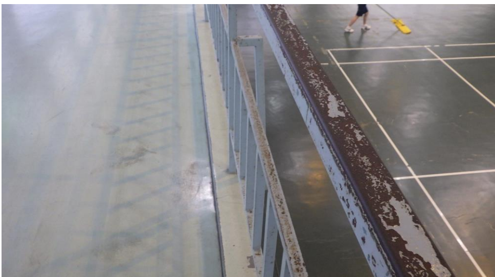
二階ギャラリーの手すり
