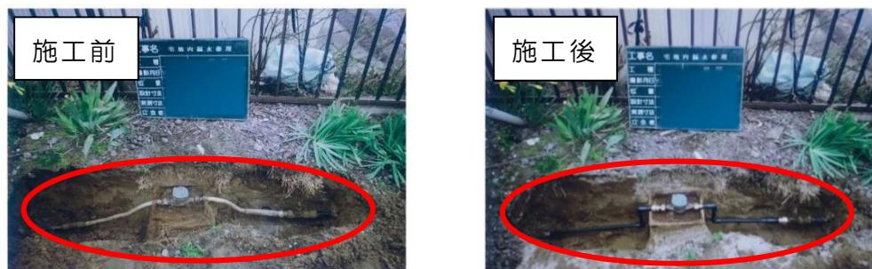
▲鉛製給水管解消のイメージ
