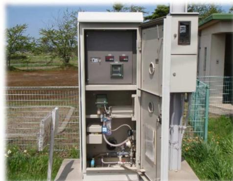
▲監視装置による残留塩素の測定
