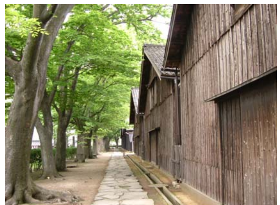
景観形成重点地域（山居倉庫周辺地区）
